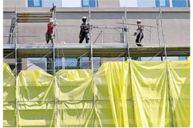
Il cantiere per il rifacimento della facciata di uno stabile ANSA
