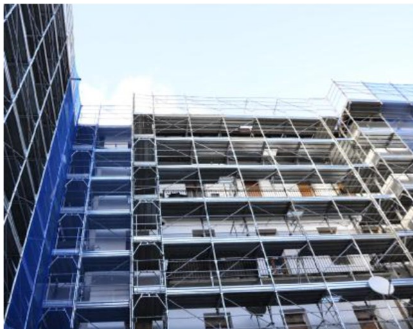
Superbonus Un cantiere edile, nel quartiere Cogne di Aosta ANSA
