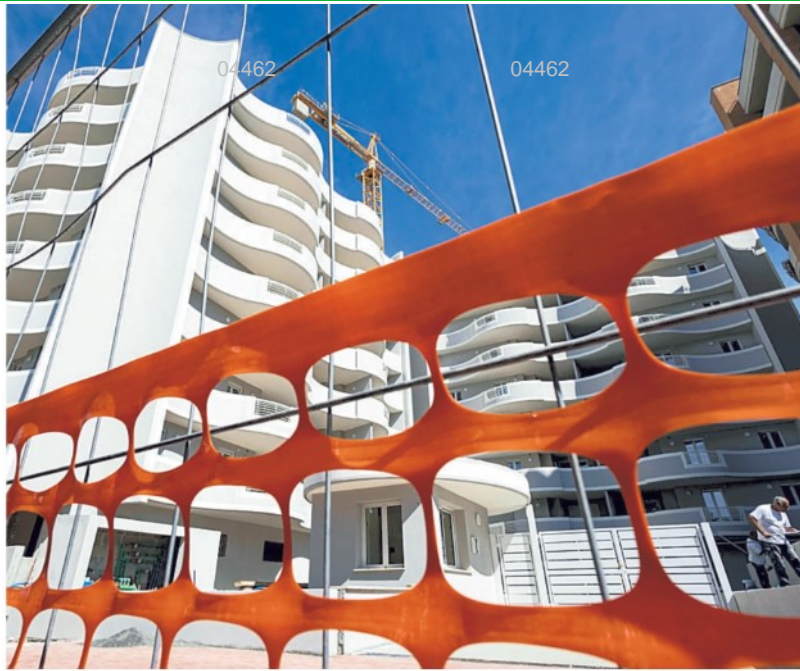
▲ Un edificio in ristrutturazione
