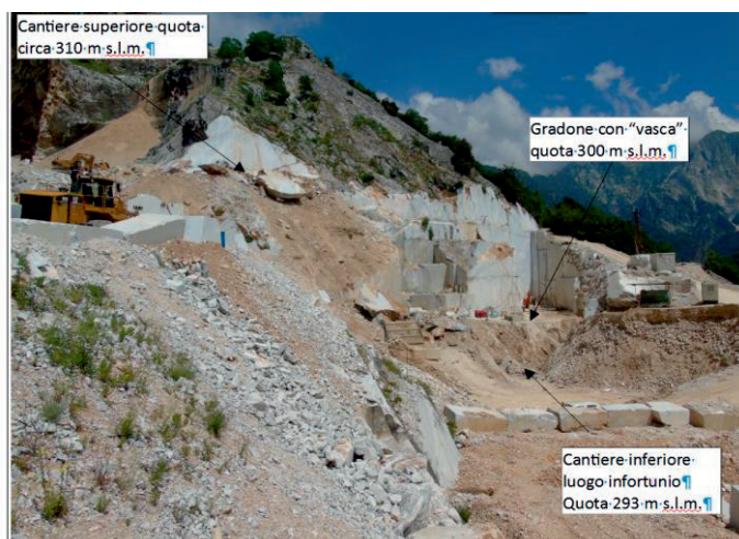
Foto 3 - distribuzione dei cantieri
