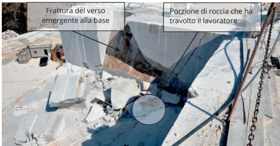
Foto 3 - area di distacco della porzione di roccia
