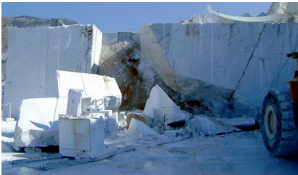
Foto 1 - Fotografia rappresentativa del luogo di lavoro dopo l'incidente
