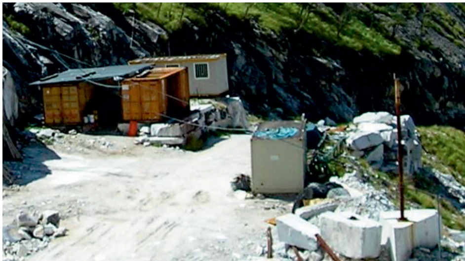
Foto 2 - area servizi e generatore
