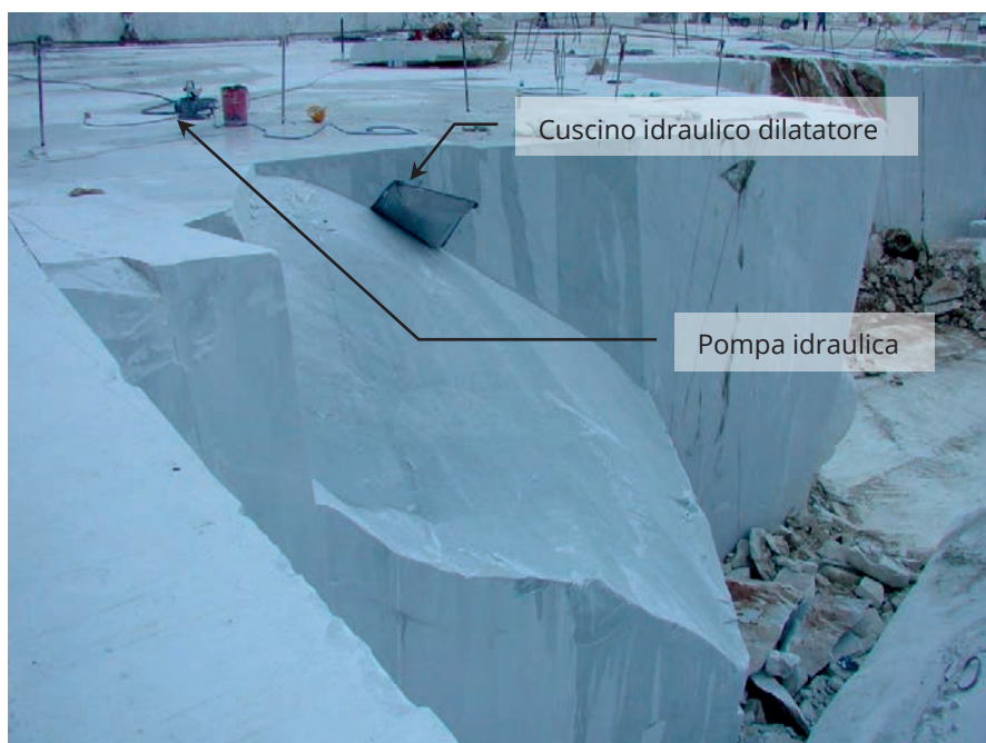
Foto 3 - area di lavoro con cuscino e pompa idraulica
