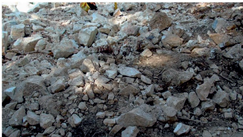
Foto 3 - Fotografia rappresentativa del luogo in cui è caduto il lavoratore
