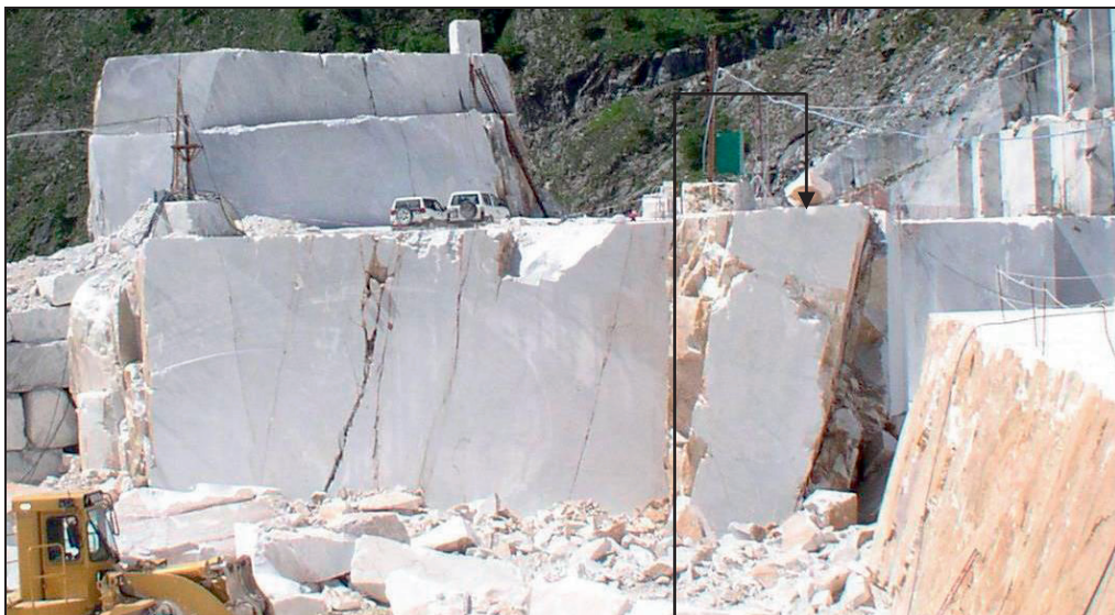
Foto 1 - fotografia rappresentativa del luogo di lavoro dopo l'infornio
