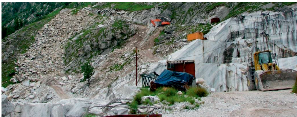
Foto 1 - vista della cava di marmo a cielo aperto
