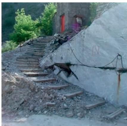
Foto 11 - esempio di passaggio attrezzato con traverse in legno per il raggiungimento di una cabina elettrica
