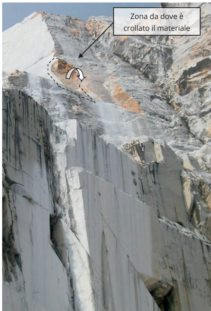
Foto 2 - area di distacco del materiale franato
