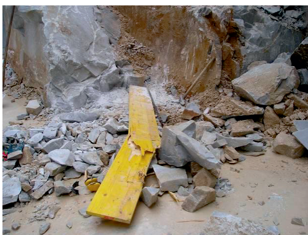
Foto 3 - corpo di frana
