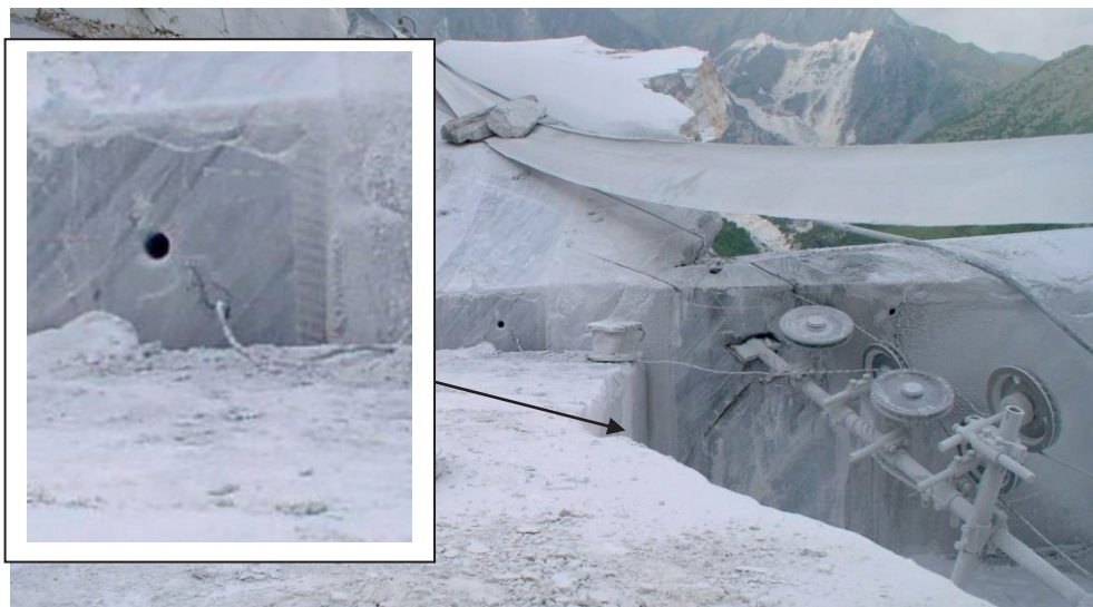
Foto 5 - particolare del punto di uscita del filo diamantato strappato
