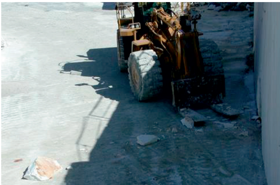
Foto 1 - fotografia rappresentativa del luogo di lavoro dopo l'incidento
