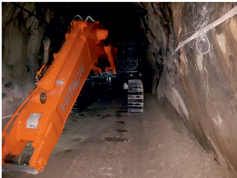
Foto 1 - vista dell'escavatore all'interno della strada in galleria di accesso alla cava
