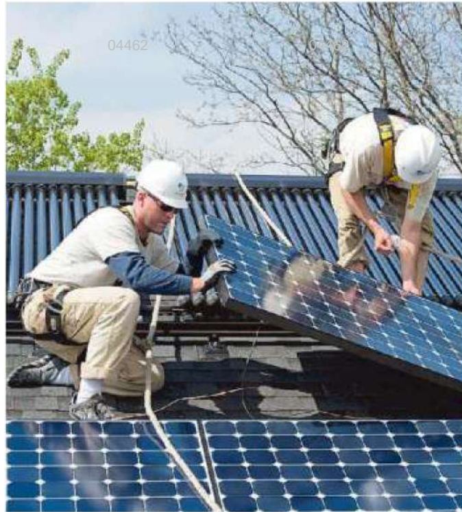
I pannelli solari sul tetto fanno parte dei lavori coperti dal superbonus
