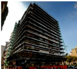
Edificio in ristrutturazione ANSA
