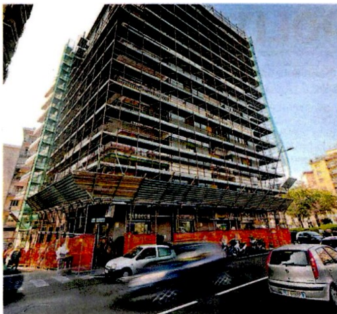
Un edificio in ristrutturazione (Ansa)
