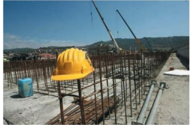
●●●● ALLARME L'immagine simbolo di un cantiere edile
