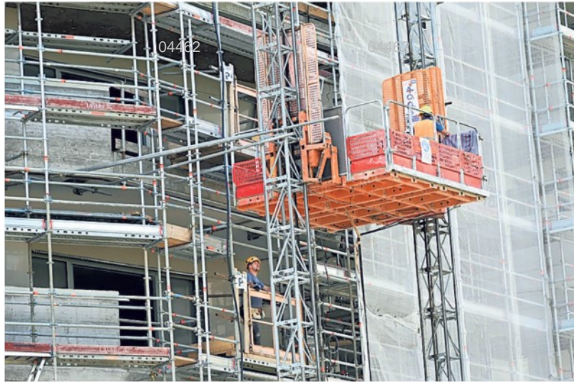
▲ Al lavoro Uno dei tanti cantieri torinesi del superbonus
