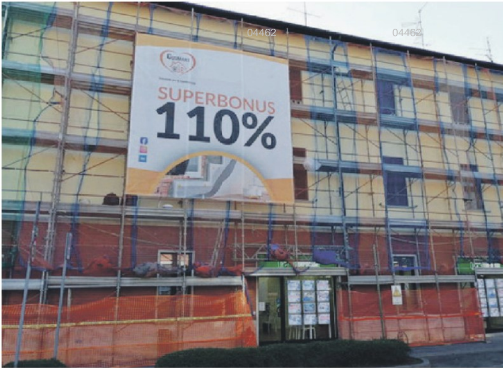
Un palazzo in ristrutturazione grazie al Superbonus 110%
