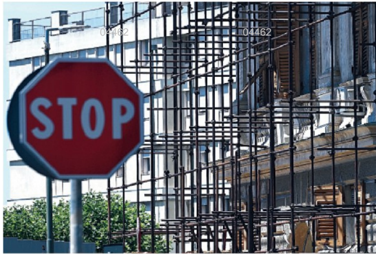
Cantieri fermi. Artigiani e commercianti aspettano ancora i pagamenti
