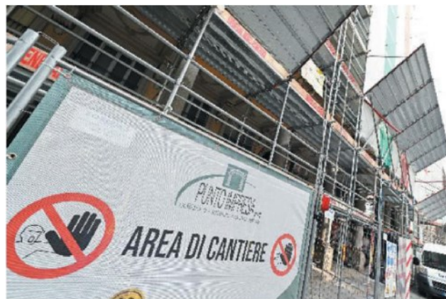
CRISI Un cantiere edile in una foto di archivio
