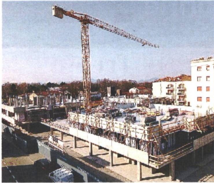
SUPERBONUS Uno dei tanti cantieri aperti in questi mesi Veneto
