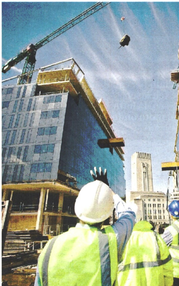
Operai al lavoro in un cantiere edile
